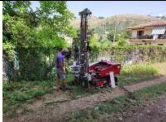
*Prova penetrometrica statica CPT04*
